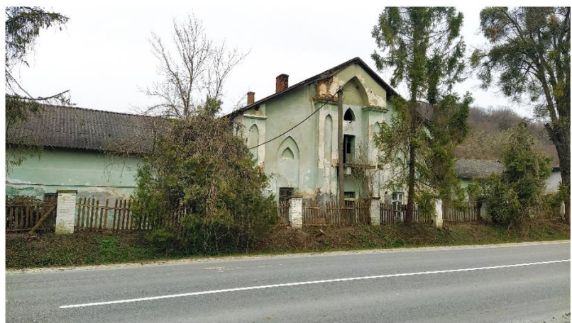
Фото 2. Фасад цеху, який заплановано реставрувати
