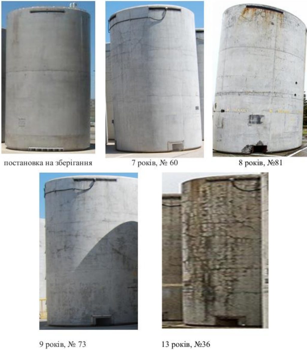
Рис. 6. Стан поверхні контейнерів після перебування на місці зберігання згідно картограми розміщення ВКЗ
